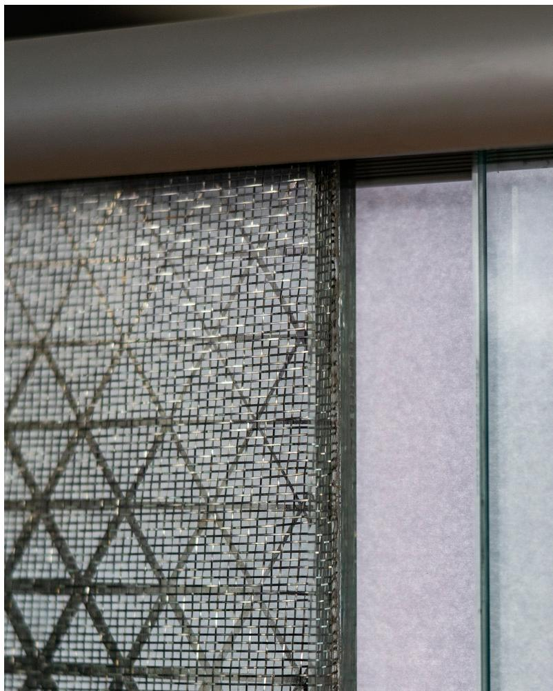
**NAPOMENA:** Radi metalnih mrežica u Rope Weave modelima nije moguće idealno očistiti spojeve laminiranih stakala.
